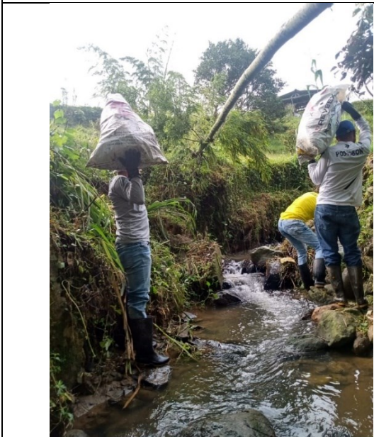
Retiro de residuos sólidos de la quebrada
