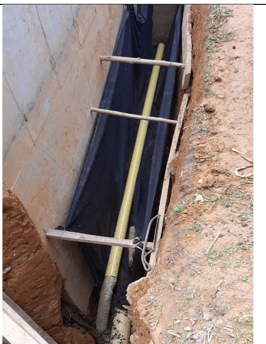
Foto 6 Instalación de tubería de 4" perforada manualmente para reemplazar tubería de filtro que se retiro por estar colmatada
