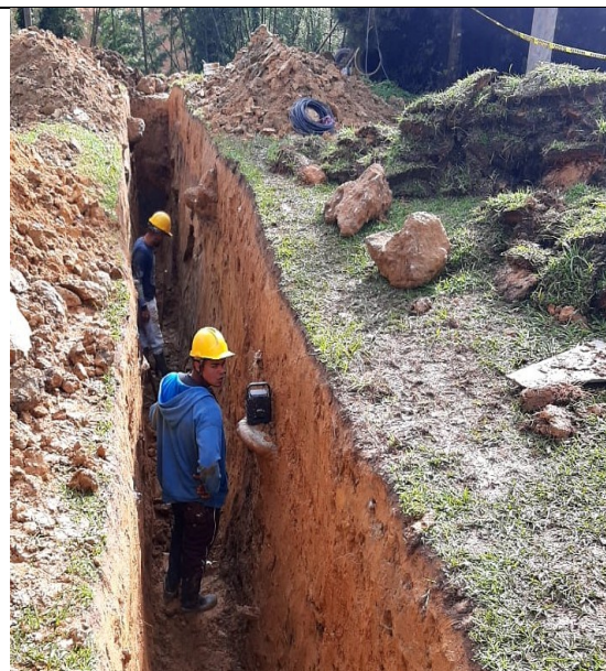
Foto 4: Perfilación de la excavación
