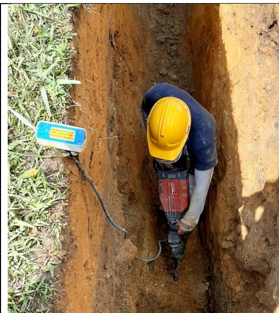
Foto 3: Utilización de taladro para devastar roca
