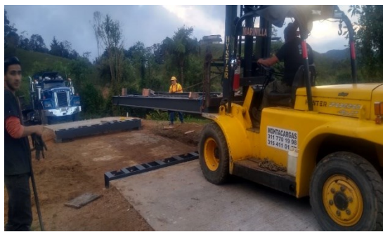
Foto 3: Desplazamiento de los módulos que conforman la plataforma al sitio de instalación
