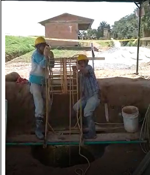
Excavación Pilas
