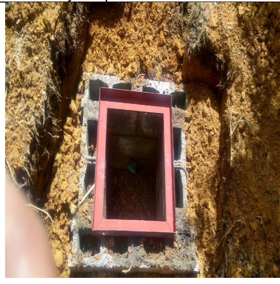
Foto 2: Excavación en suelo conformado en su mayoría por basura
