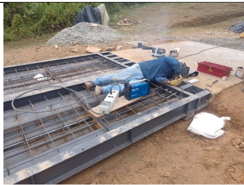
Foto 6: Soldadura de los topes
