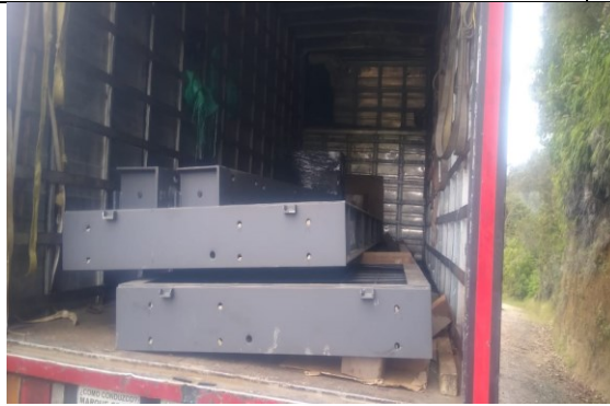
Foto 1: Llegada de la Plataforma y demás elementos para la Bascula a la obra procedente de las instalaciones de NABA en la ciudad de Cali
