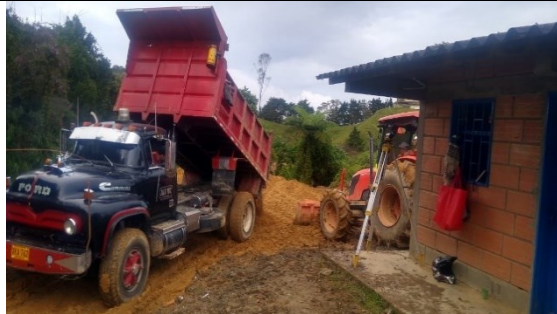
Foto 3: Paso de la tubería PVC DB 2" encamisada en tubería metálica galvanizada 3"
