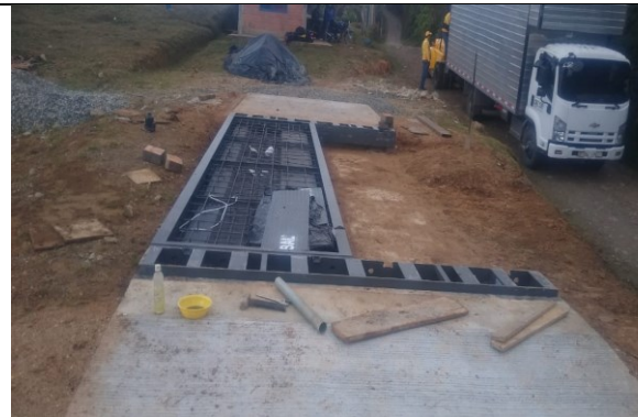
Foto 4: Colocación de un modulo de la plataforma en su sitio
