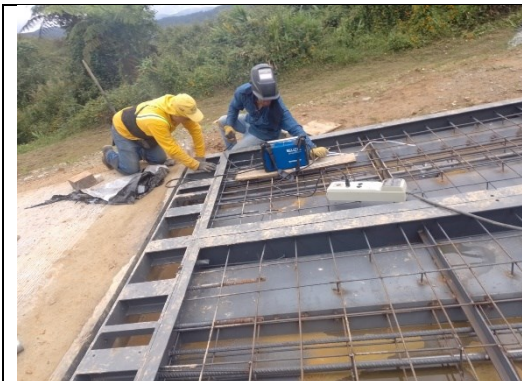
Foto 5: Trabajos de ensamble y soldadura de algunos elementos de la plataforma
