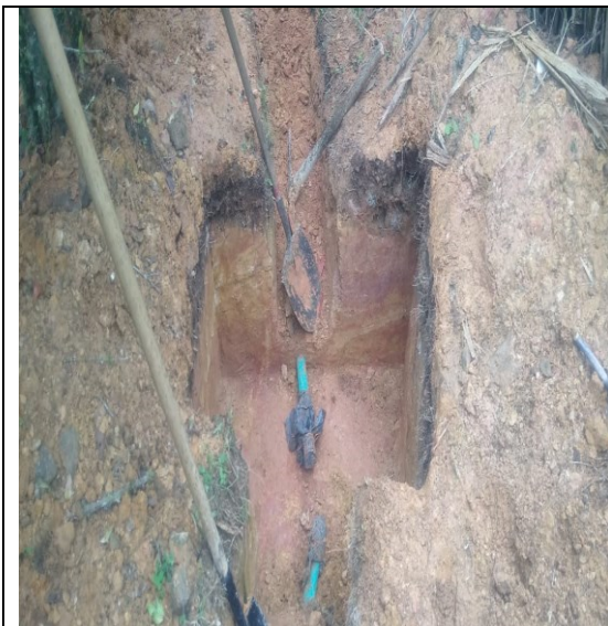
Foto 1: Llegada de tubería DB 2" al espacio previsto para la caja
