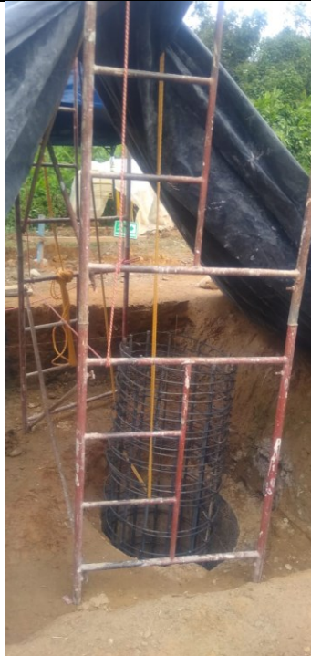
Foto 3: Construcción de Pilas
