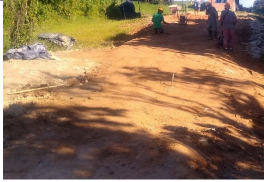
Foto 3: lleno y compactación en rampa de acceso a bascula
