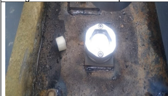
Foto 7: Soldadura de la base de las celdas
