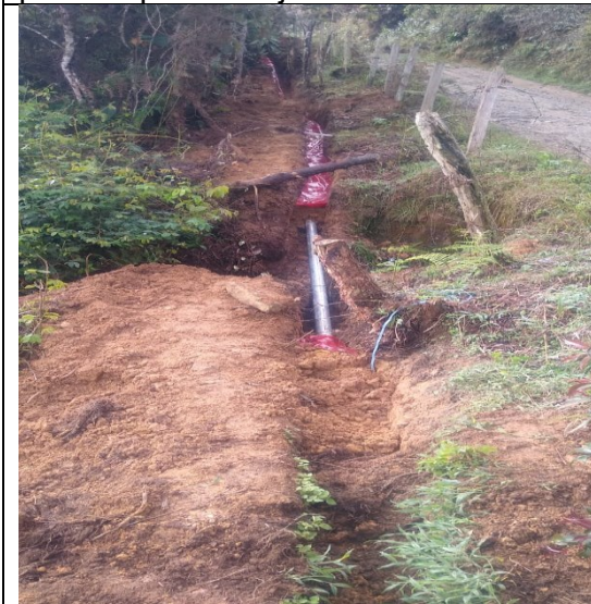
Foto 1: Llegada de tubería DB 2" al espacio previsto para la caja
