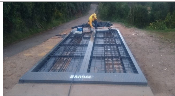
Foto 8: Plataforma de la Bascula lista para recibir el concreto
