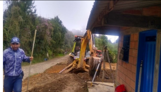
Foto 4: Construcción cajas Norma RS3-01
