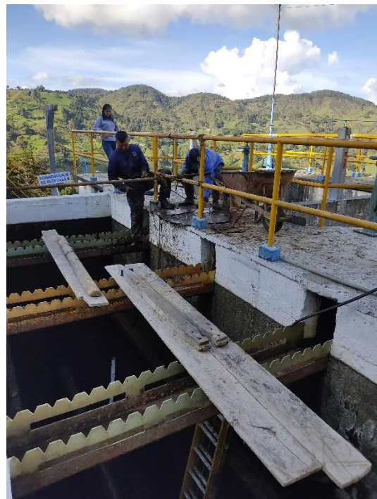
Paneles plásticos tipo colmena
