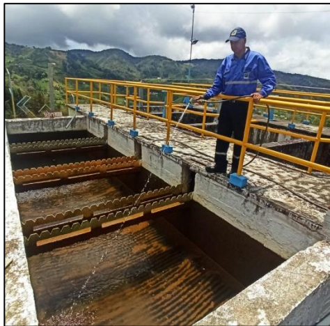
Fig 26. Limpieza y purga del sedimentador de alta tasa.
