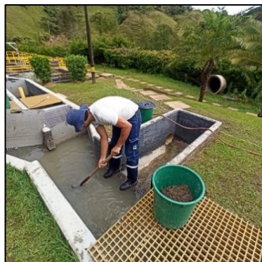
Fig 8. Limpieza del canal de entrada.
