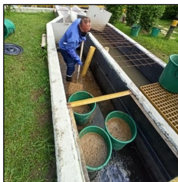
Fig 12. Extracción del material en el canal desarenador.
