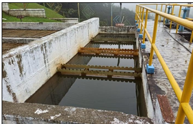
Fig 25. Sedimentador de alta tasa.
