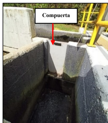
Fig 18. Vertedero lateral después de preliminares.
