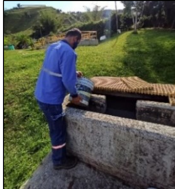
Fig 28. Operario realizando disposición del material extraído en los FAFA.
