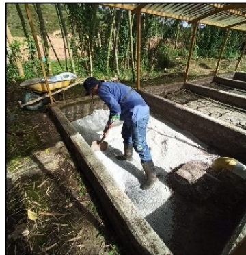
Fig 40. Operario reponiendo arena en los lechos de secado.
