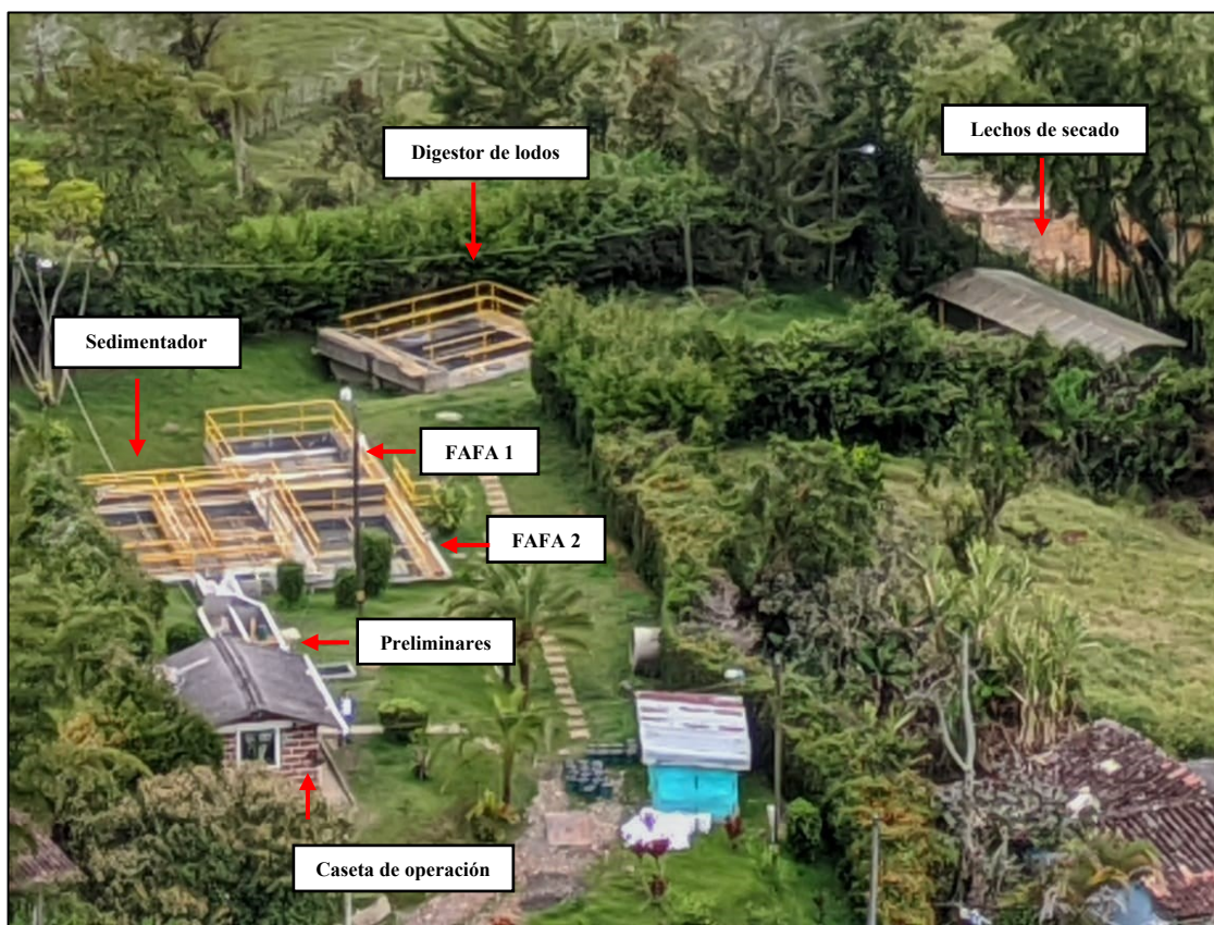
Fig 4. PTAR del municipio de Granada.
