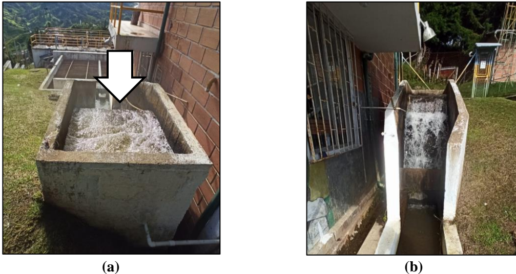
Fig 13. Cámara de quietamiento y sistema de aireación
