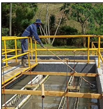
Fig 20. Limpieza del sobrenadante en el sedimentador primario de alta tasa.
