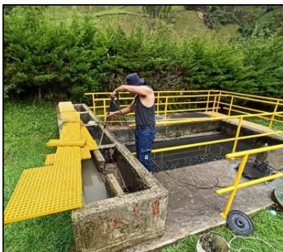
Fig 32. Limpieza en los múltiples de distribución con hidrolavadora.
