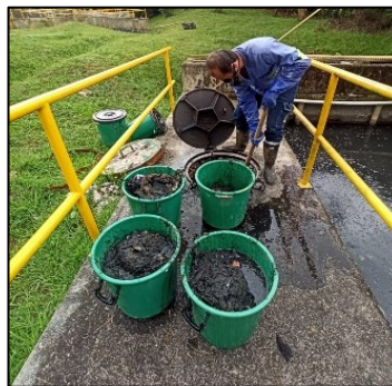
Fig 34. Limpieza de las campanas del digestor de lodos.
