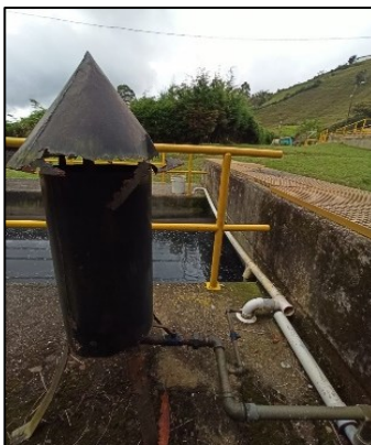
Fig 37. Quemador de biogás.
